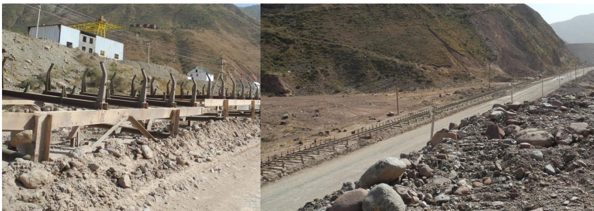
Рисунок 6-1 : Остатки участков установленного конвейера
