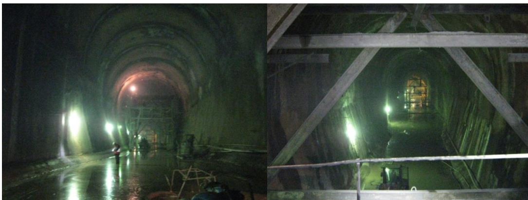
Рисунок 4-5: СТ1, отремонтированные участки на месте зоны вывала – разлом № 35
