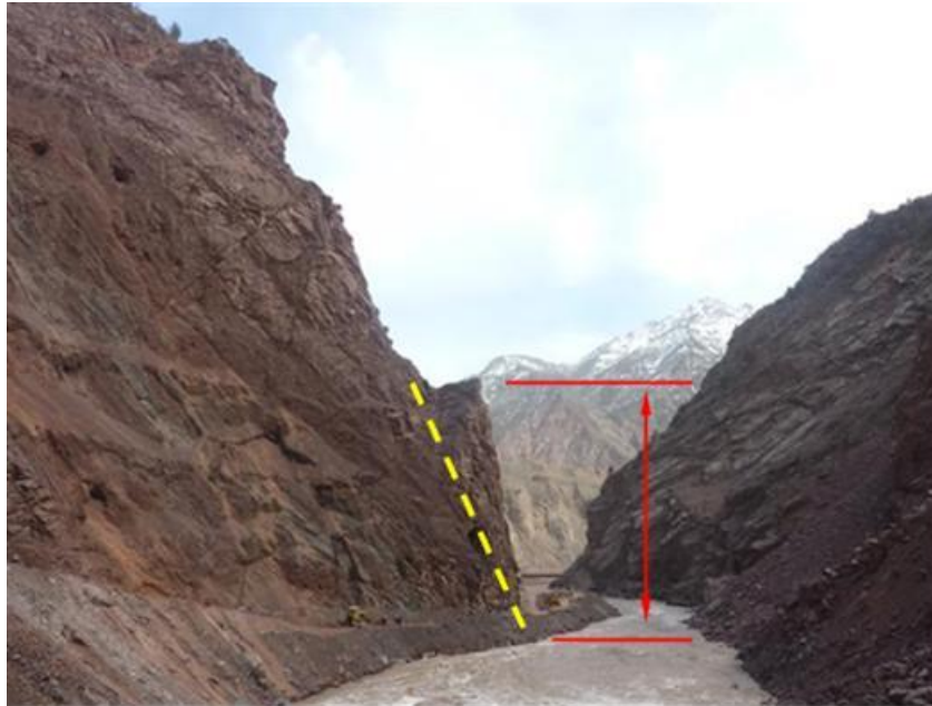
Рис. 3-5: Выемка в зоне центрального ядра
