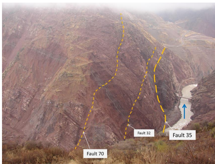
Рис. 2-2: Вид узкого ущелья реки Вахш на стройплощадке плотины.
