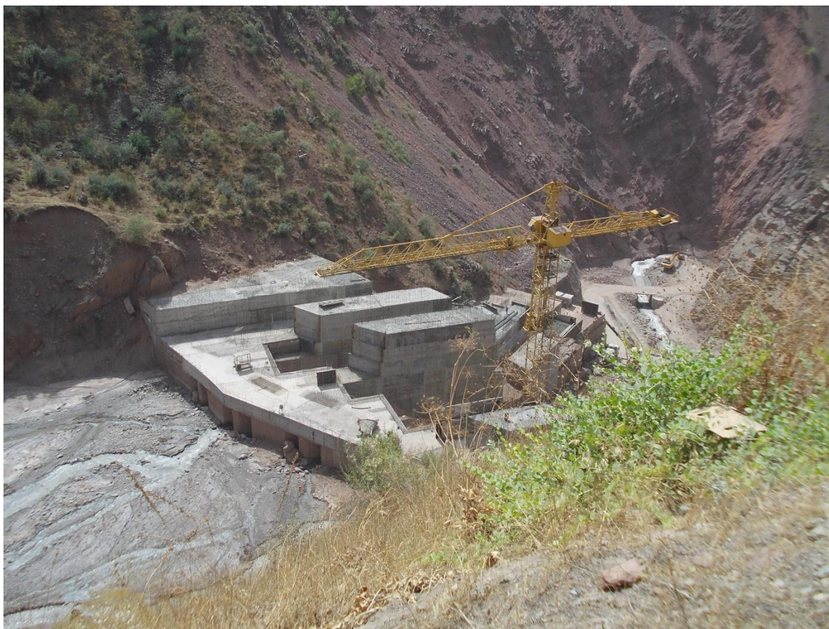
Рисунок 0.7: Плотина удержания сели Обишур в августе 2012; селевые потоки уже почти засыпали реку позади оконченной части плотины
