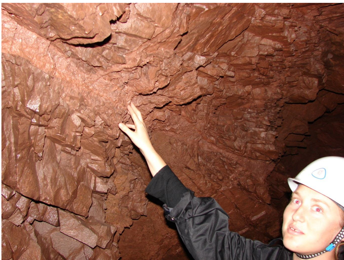
Рисунок 0.4: Кызылташская формация в изыскательной штольне 1030; можно отметить суб-горизонтальную трещину с глинистым заполнением и общую влажность породы
