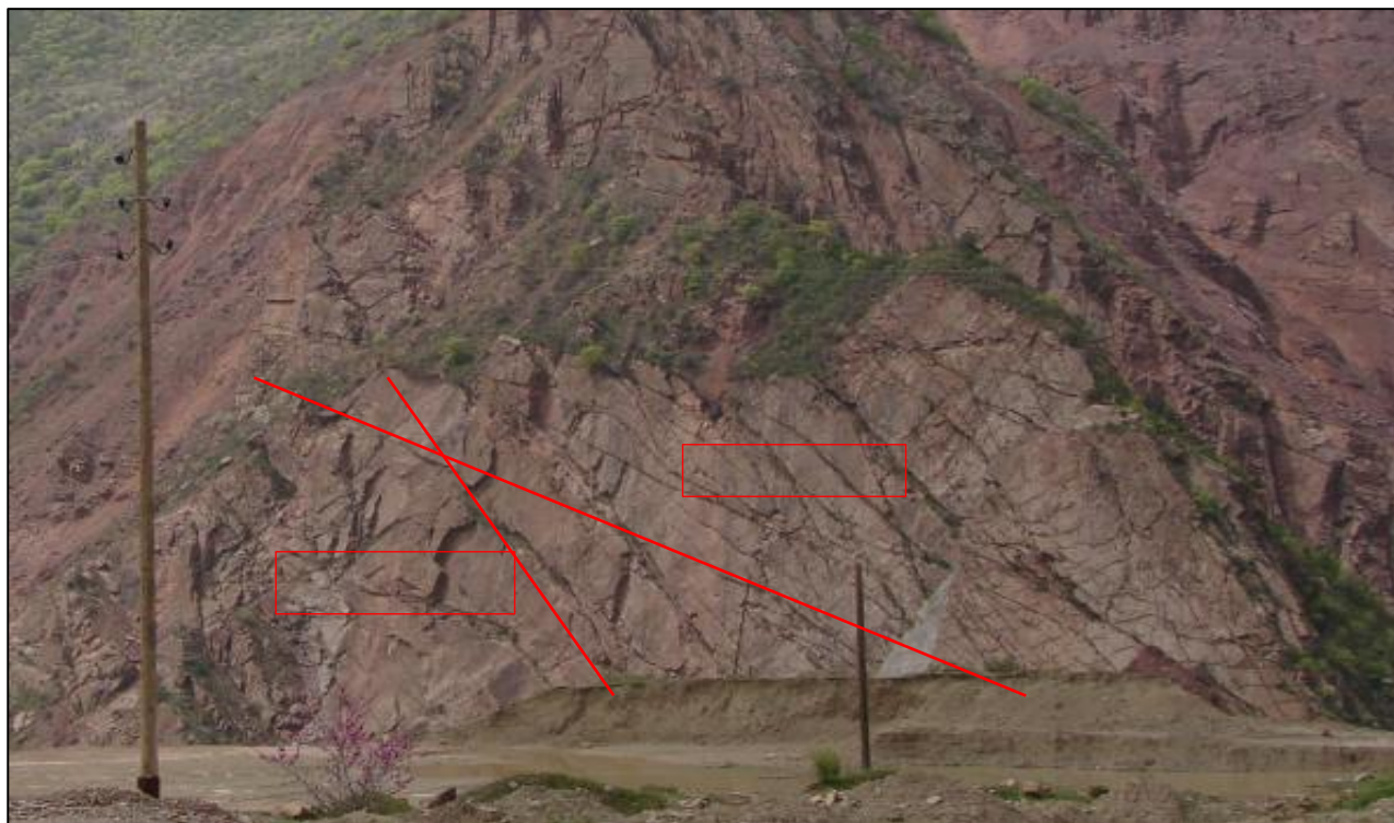
Рисунок 0.1: Фотография отрога горы в низовье правого берега, демонстрирующей системы трещин 2 и 4
