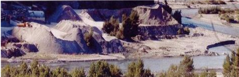
Рисунок 6.6: Удаление крупнозернистых наносов седиментации плотины Саутет (Франция)
