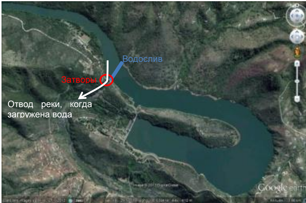
Рисунок 6.3: Плотина Недл (Южная Африка) – Перепускной канал водохранилища
