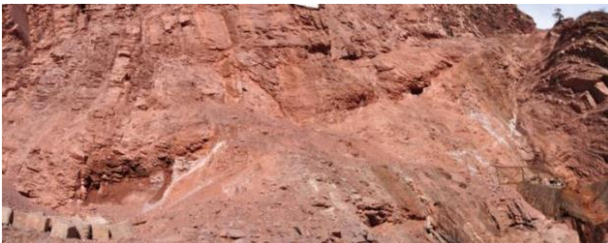
Рисунок 22. Разлом № 35 на левом устое плотины.
