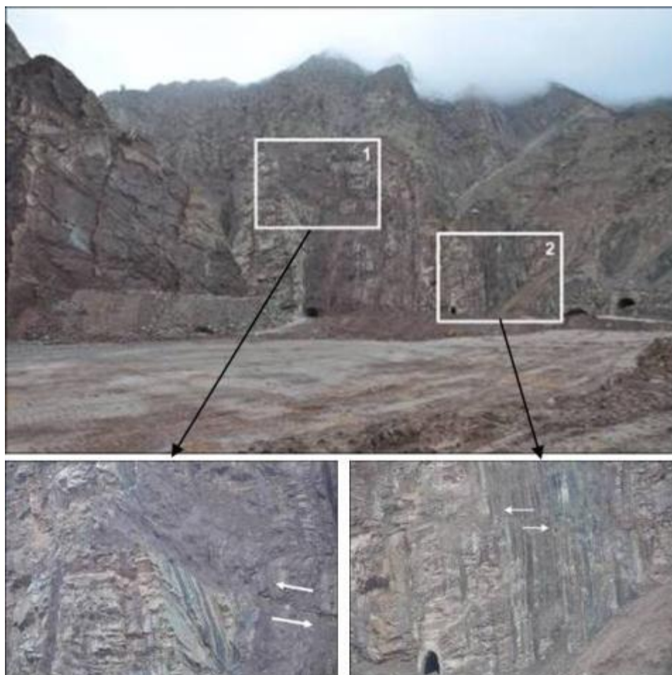
Рисунок 28. Смещения на сплошные субгоризонтальные/неглубокие разрывы, правый берег, нижний бьеф.
