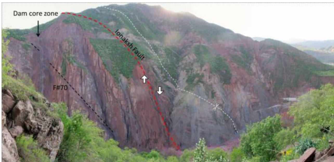
Рисунок 15. Правый берег на створе плотины
