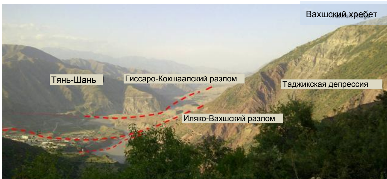
Рисунок 2. Вид верхнего бьефа с правого берега створа плотины.
