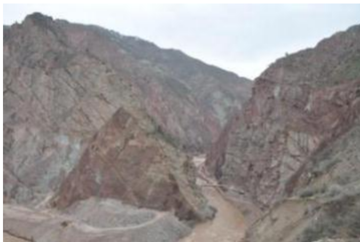
Рисунок 12. Вид створа плотины с верхнего бьефа (наверху) и с нижнего бьефа (снизу).
