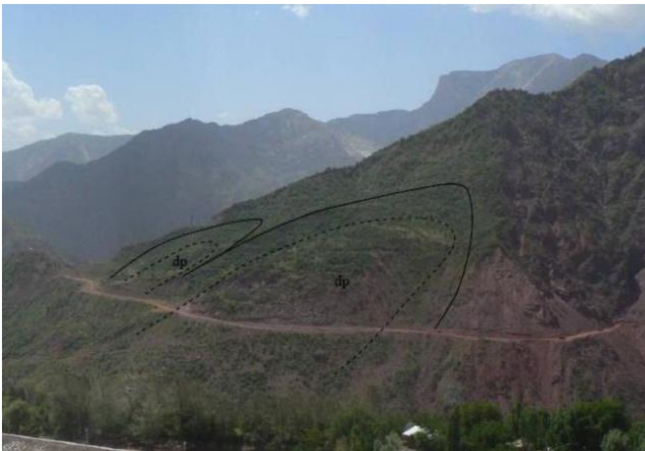
Рисунок 49. Оползень по нижнему бьефу правого берега Пассиморухо
