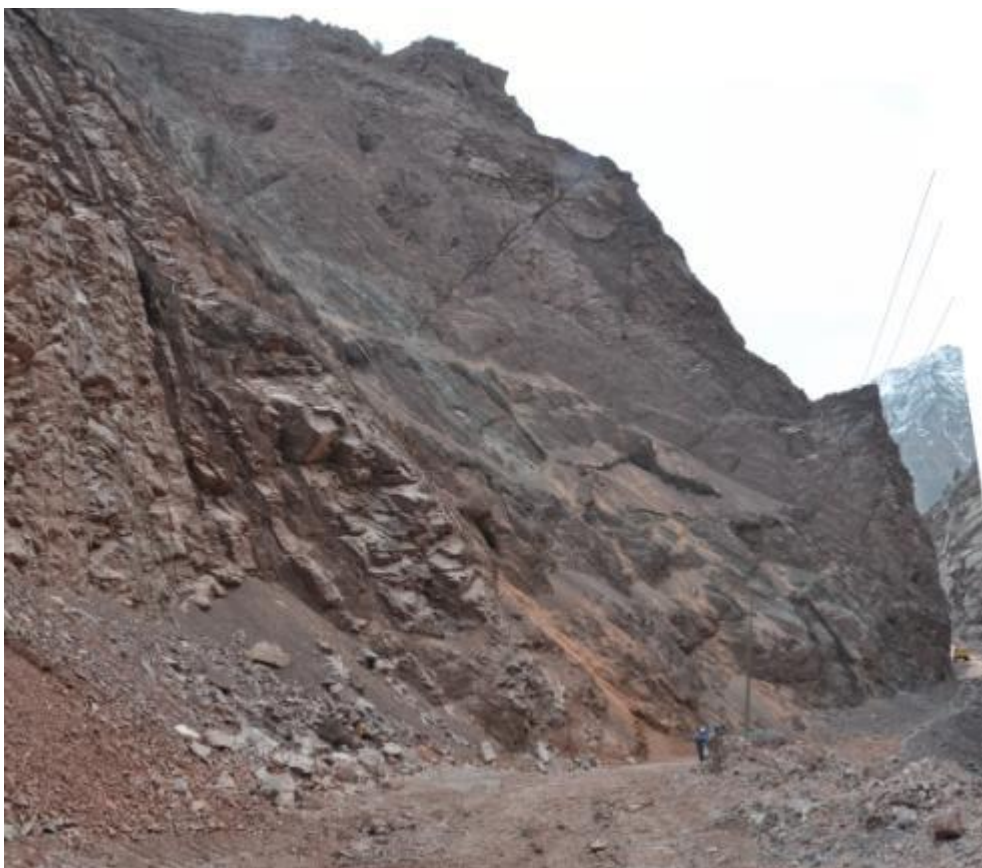
Рисунок 24. Разрывные нарушения семейства разлома № 35, падающие в сторону верхнего бьефа на левом устье.
