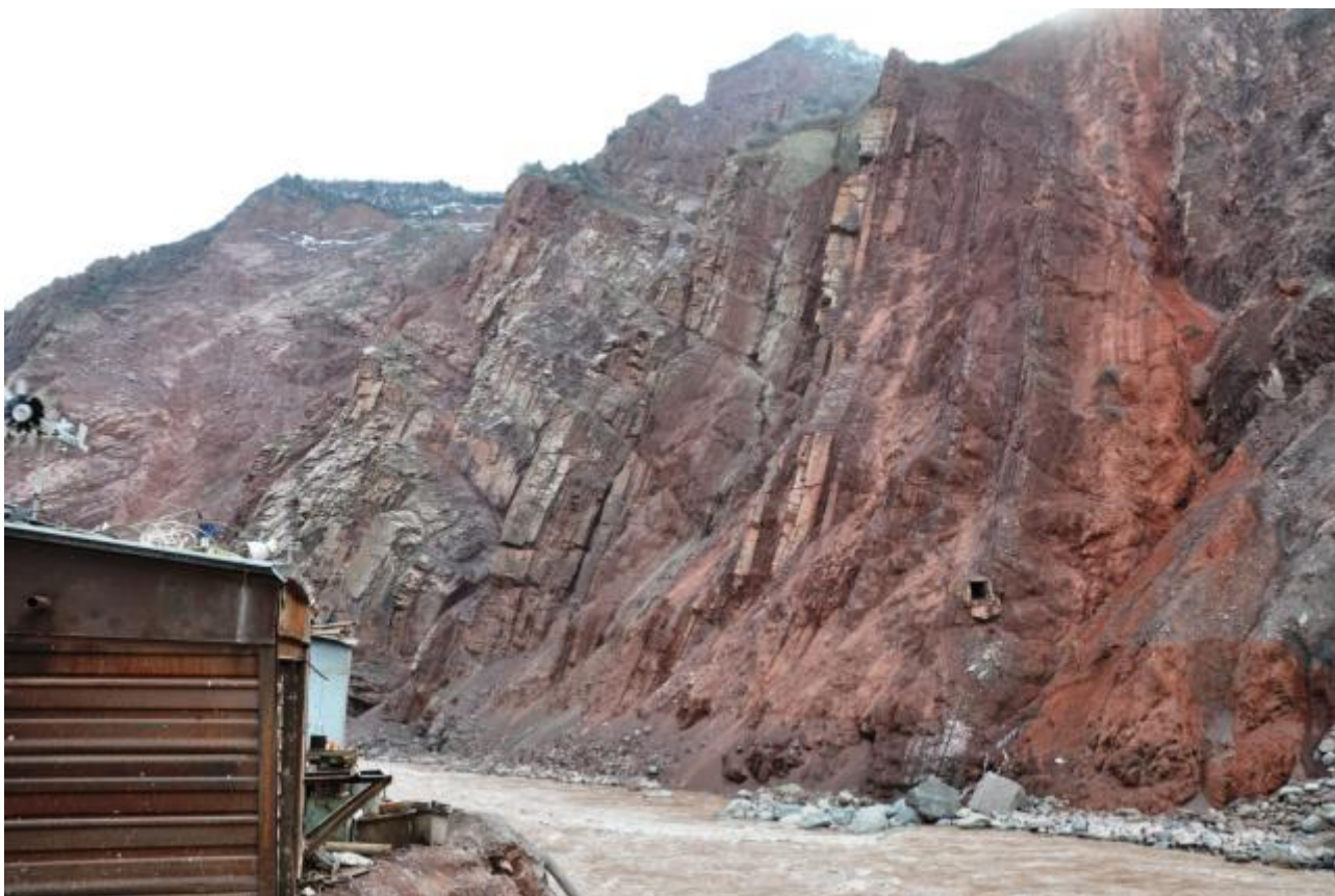
Рисунок 23. Серия разрывных нарушений семейства разлома № 35 на правом устое.
