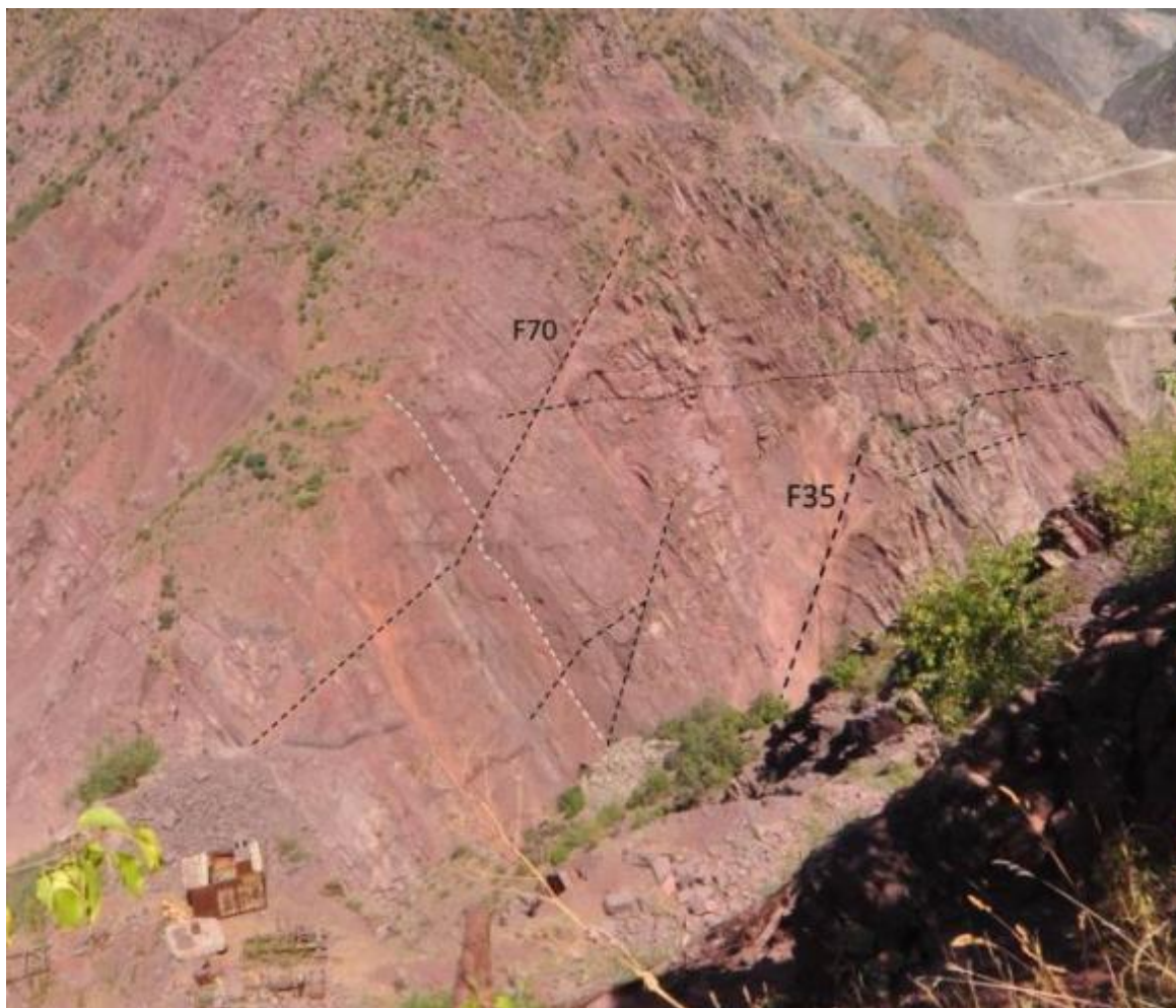
Рисунок 25. Разломы на верхней части левого устоя.
