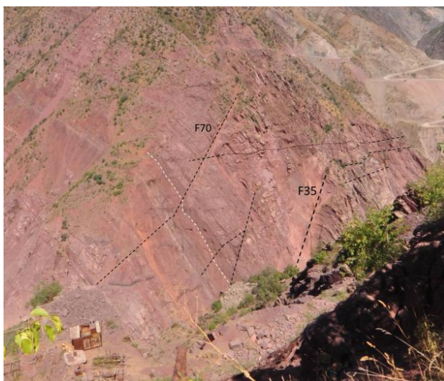
Рис. 11 – Разломы №35 и 70 на верхнем левом устое плотины. Расположение показано на рис. 10.
